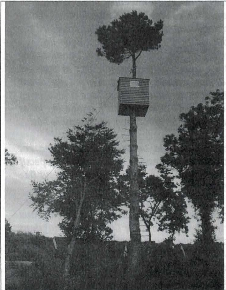
On accède à la résidence par un escalier (!) constitué de 40 tiges d'acier galvanisé de 27 mm de diamètre et de 60 cm de longueur, enfoncées de 10 cm tous les 30 cm de hauteur et régulièrement en colimaçon tout autour du tronc. Les tiges d'acier sont reliées à leur extrémité par un filin d'acier qui en assure la régularité et la sécurité. Une ligne de vie en cordage entoure l'arbre en suivant le cheminement de l'escalier et permet d'y fixer le harnais de sécurité du visiteur.
